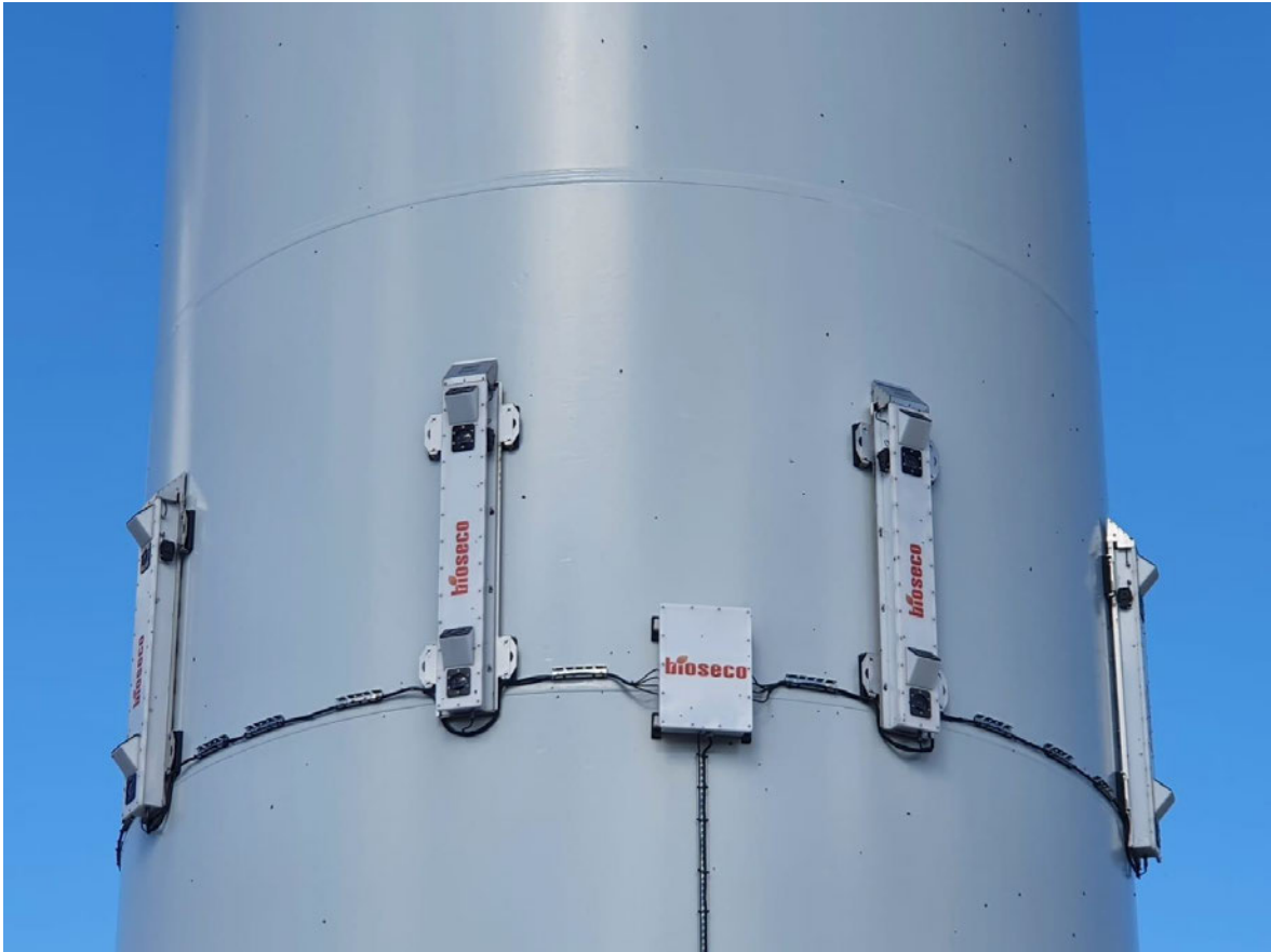
Abb. 2.4: Detailansicht der einzelnen Detektionsmodule von Bioseco (Foto: BioConsult SH 2022).
