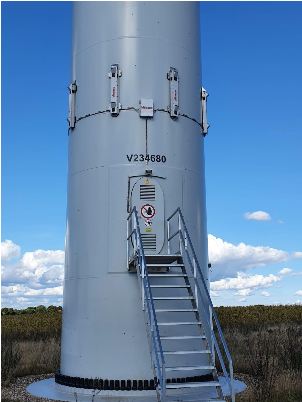
Abb. 2.3: Die Vestas WEA in Lentföhrden mit acht installierten Bioseco-Systemen in 7 m Höhe (Foto: BioConsult SH 2022).
